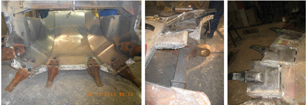
Слика 16. Припрема постојеће ведрце багера ведричара
